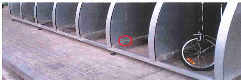
Vista de les argolles instal·lades a la base del mòdul en una prova pilot
